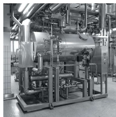
Reindampferzeuger Clean steam generator
